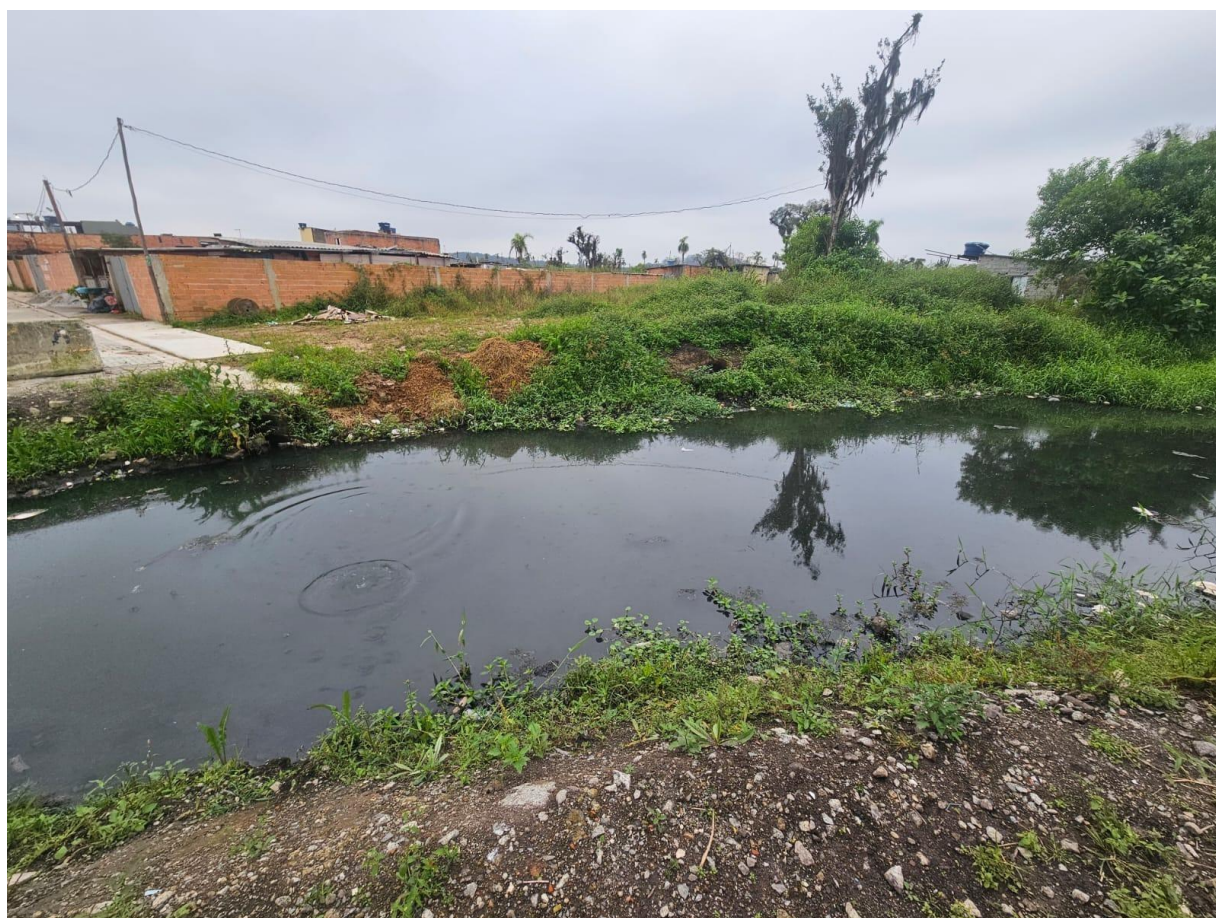
Foto 3 – Vista interna da cratera, próximo ao limite do bairro em direção ao centro da cratera, evidência a densidade habitacional no fundo de vale e suas consequências ambientais. Acervo dos autores, 30 mai. 2026.
